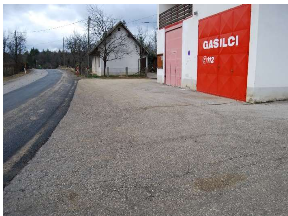
Postajališče v naselju Hinje - pri gasilskem domu
